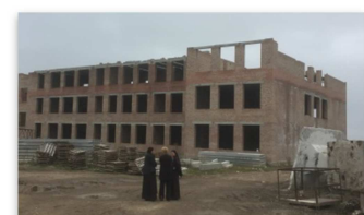
Baustelle der neuen Schule
